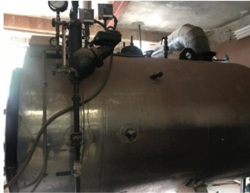
**Fotografía 8.** Caldera Power master de 40 BHP que opera con gas natural como combustible
